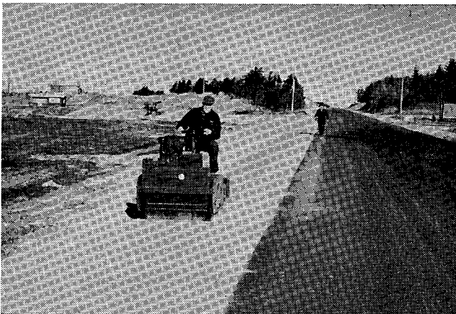
Abb. 5: Aussaat im Sand; Walzen fördert die Grasetablierung
