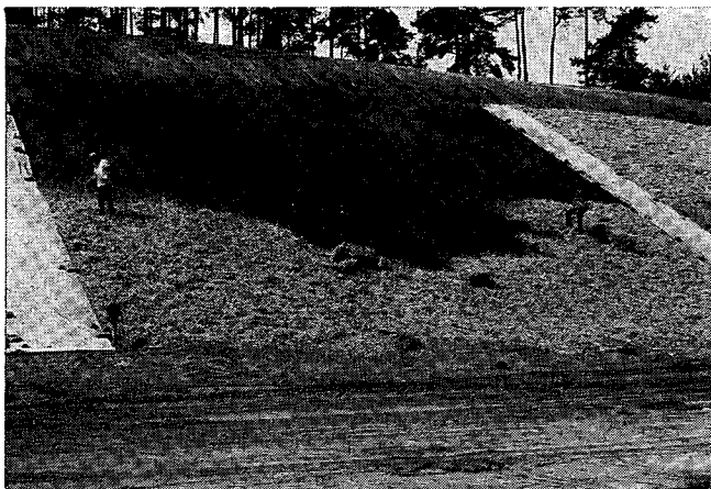
Bild 7: Manuelle Aufbringung einer Mulchdecke
