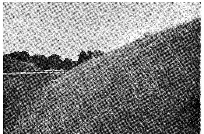
Abb. 3: Mit gezüchteten Rasengräsern in richtiger Zusammensetzung angesäte Böschung; nach 4 Jahren immer noch 100% Grasbedeckung
