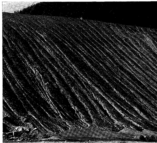
Abb. 6: Starke Rillenerosion in Böschung, die durch Normalsaat nach vorheriger Mutterbodenanddeckung begrünt wurde.
