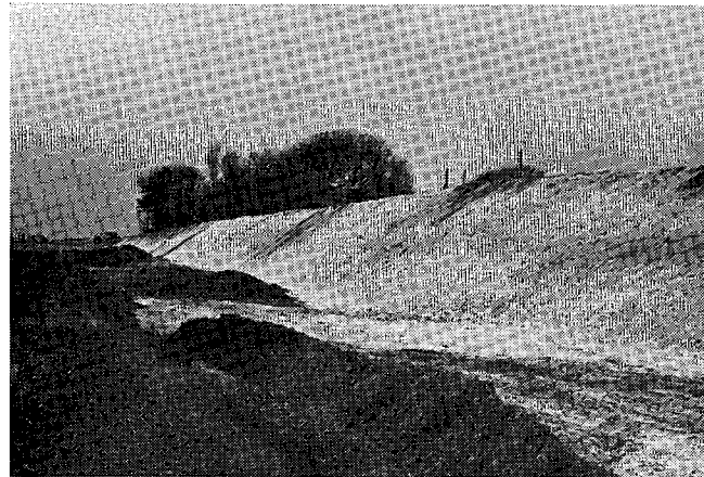
Abb. 6: Böschungen aus reiner Kreide ohne Strohabdeckung, aber mit Latexbindemittel angesät
