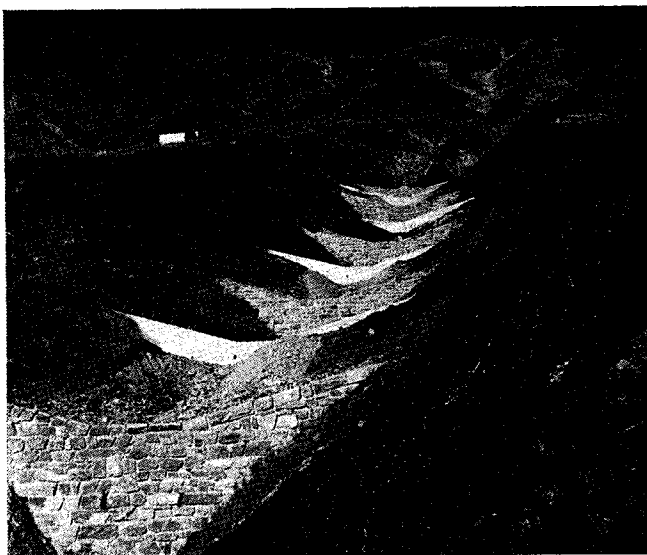
Abb. 11: Sicherungsarbeiten in Wildbachgebieten: nach technischer Verbauung Flächensicherung durch Mulchsaat; ein Jahr später Aufforstung mit Grünerlen und Nadelbäumen.
