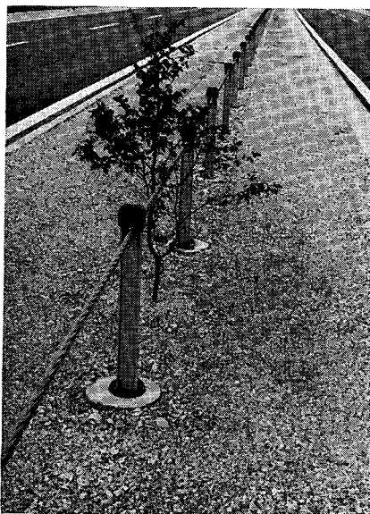
Abb. 1: Kieskoffer auf Mittelstreifen, der direkt mit Hydrosaat-Extensivrasen angesät wird
